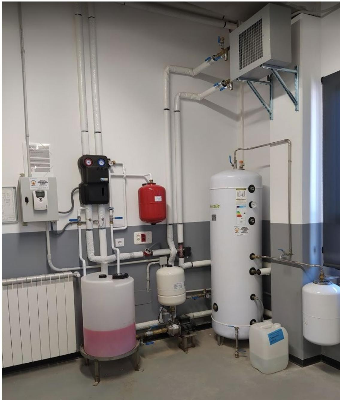
Ilustración 45. Instalación solar térmica
