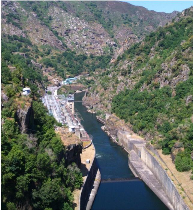
Después del recorrido por las centrales, se realizó la visita a la presa de San Esteban donde el jefe de explotación les facilitó los datos más significativos de la presa de arco de gravedad. La altura en la coronación de la presa es de 115 metros de altura y cuenta con 6 aliviaderos.
